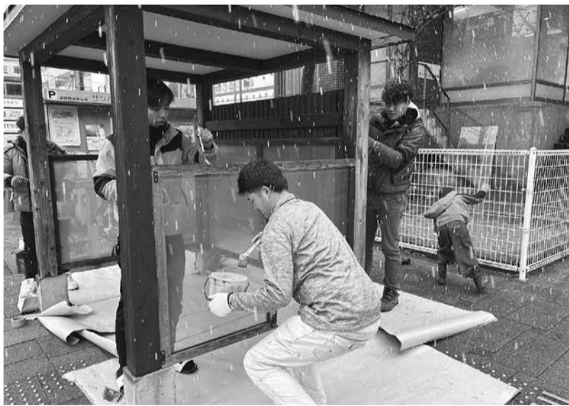
悪天候での塗装作業
